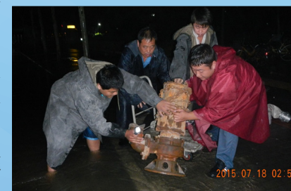
工程部人员正在进行积水外排抢险工作
