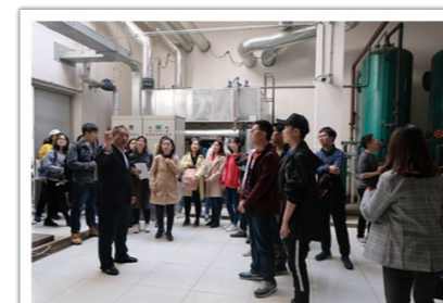
在锅炉房和配电室参观学习
