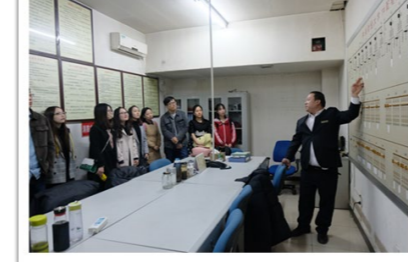
在锅炉房和配电室参观学习
