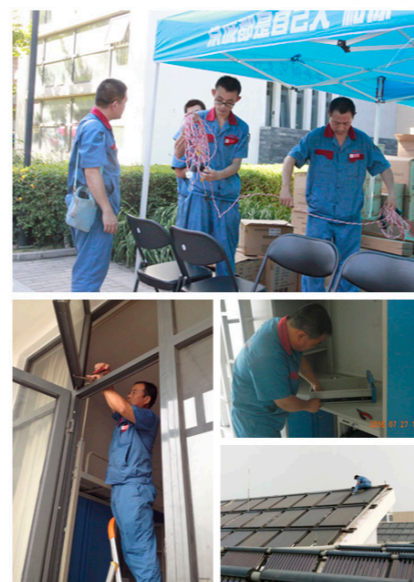
暑期校园设备设施维修、迎新卖场拉电线
